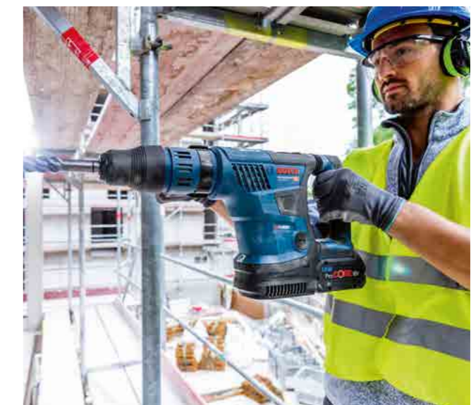
Martello GBH 18V-45 C: la distanza di foratura realizzabile con ogni carica della batteria ProCORE18V 12,0Ah con punta da 25 mm nel calcestruzzo C30/37 è di 427 cm - corrispondente a 14 fori da 30 cm di profondità. Test eseguito e certificato dall'istituto autonomo tedesco DEKRA - Dekra Testing and Certification GmbH per conto di Bosch Power Tools GmbH in data 02/2020 (numero report: 3414140.04).
